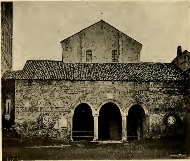
Fig. 151 — Facciata della chiesa di Santa Maria di Pomposa (sec. VI e sec. XI)
